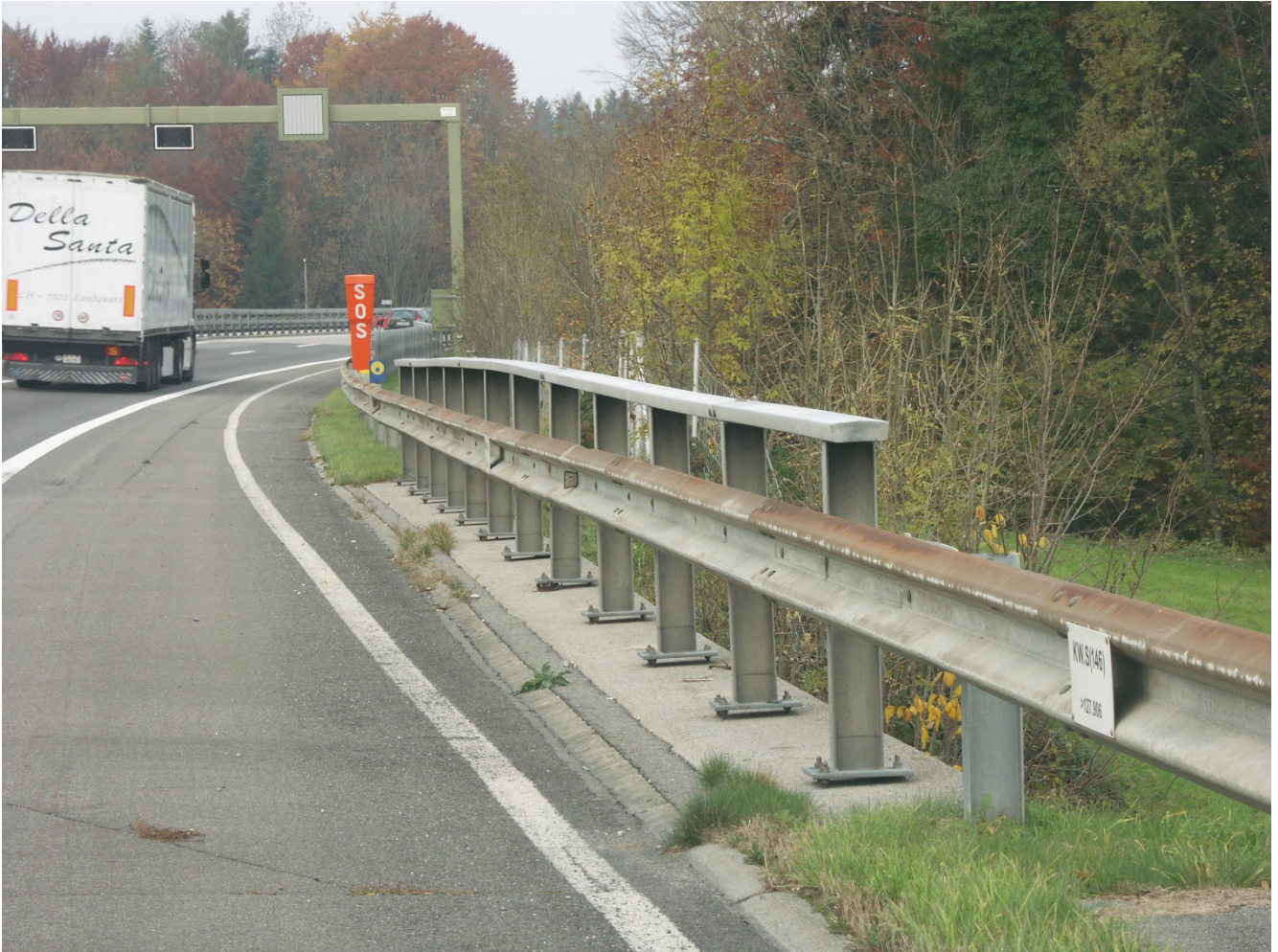
Abb. 5 Nachweis der Funktionstauglichkeit/Leistungsfähigkeit des Systems gemäss Norm SN 640 567-2 nicht vorhanden. Des Weiteren starke Korrosionsschäden. Ersatz des Systems unter Beachtung der Norm SN 640 561 und der Richtlinie für Fahrzeugrückhaltesysteme Aufhaltestufe H1 bei kein Schutz Dritter gleich System 6411 oder Aufhaltestufe H2 bei Schutz Dritter gleich System 6611, Mindestlängen, Übergänge.)
