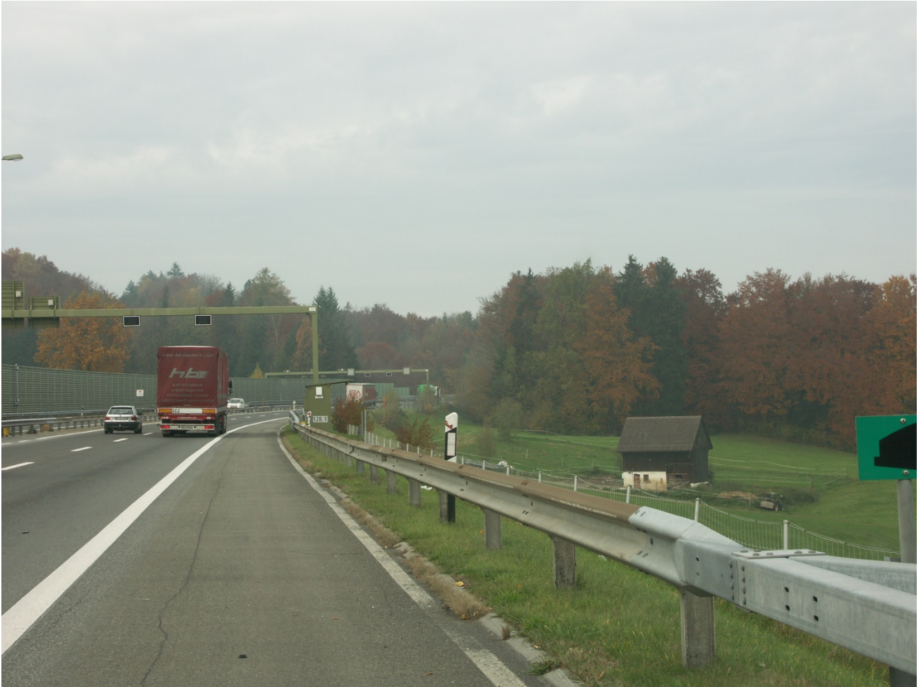
Abb. 2 Funktion des Systems aufgrund starker Korrosionsschäden nicht mehr gewährleistet. Fachgerechte Reparatur nicht mehr möglich. Ersatz durch System 6211 (Aufhaltestufe H1)
