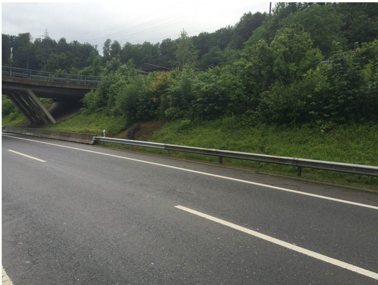
Abb. 6 Reparatur des Übergangs des Leitschranksystems mit Planke Profil A unter anderem aufgrund von zu grossen Pfostenabstand von 4.0 m nicht konform zu den Vorgaben der Richtlinie für Fahrzeugrückhaltesysteme gemäss Zeichnung 9132 mit Pfostenabstand von 1.33 m.
