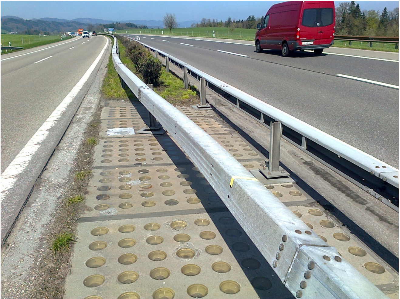
Abb. 4 Systemfunktion aufgrund unzulässiger Verklebung der Pfosten auf Glasbausteine nicht gegeben. Erhöhte Gefährdung der Verkehrsteilnehmer auf der Gegenfahrbahn durch sich lösende Pfosten. Prüfung des Einsatzes eines mobilen Systems unter Einsatz von fachgerechten Übergangskonstruktionen.
