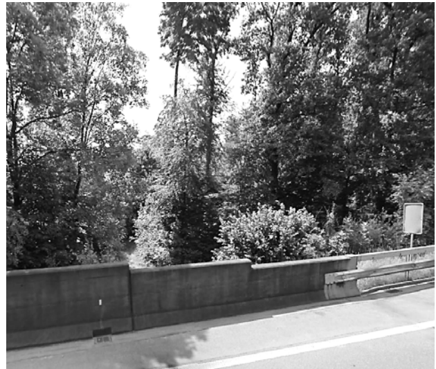
Nicht richtlinienkonformer Übergang LS 9232 Transition GS 9232 non conforme aux directives
