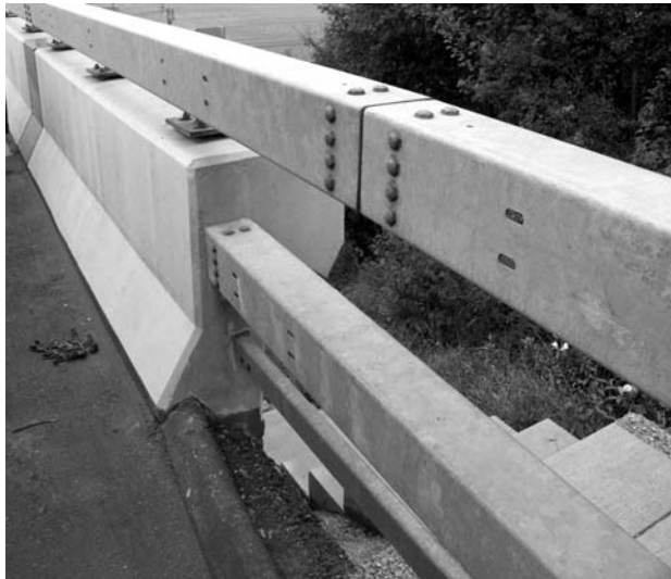
Nicht richtlinienkonformer Anschluss LS 9332 Transition GS 9332 non conforme aux directives
