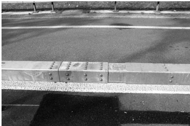
Dilatation Kastenprofil 150'180 Caisson 150'180 de dilatation
