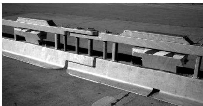
Schnellöffnungspunkt System MÜF CH Élément d'ouverture rapide système MÜF CH
