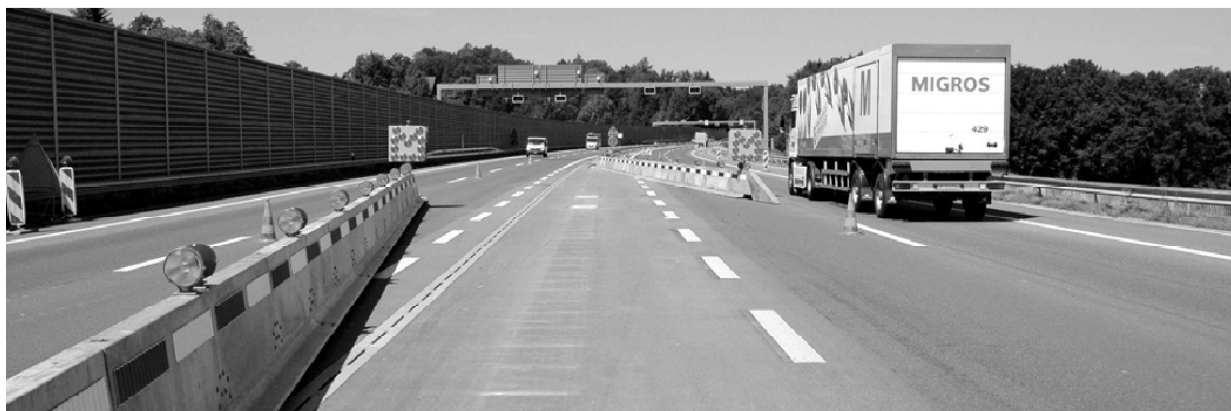
Vollautomatisierte schnell zu öffnende Schutzeinrichtung (MÜLS) im geöffneten Zustand Système de retenue à ouverture rapide entièrement automatisé (MÜLS) ouvert
