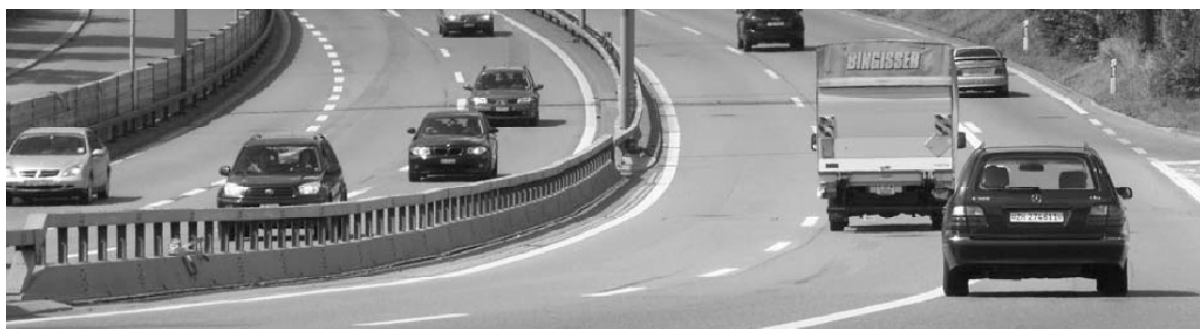
Schnell zu öffnende Stahlschutzwand im Bereich einer Mittelstreifenüberfahrt Paroi de protection en acier d'ouverture rapide pour passage de déviation en berme centrale
