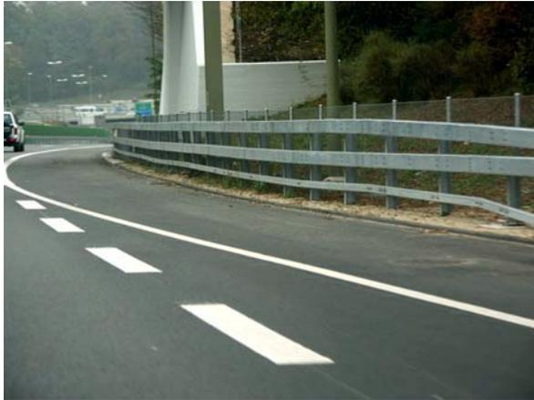
Dieses C-Profil ist alleinig für eine erhöhte Sicherheit im Hinblick auf den Anprall von Personenwagen (Prüfung TB 11 nach SN EN 1317-2) erforderlich.
