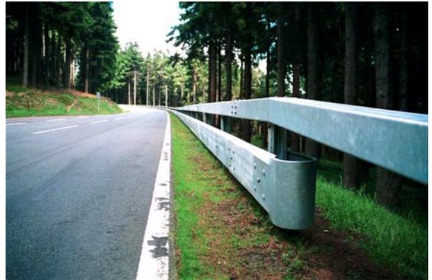
La protection inférieure doit avoir la propriété d'absorber une partie de l'énergie du choc du corps contre le système et doit guider le motocycliste le long de la protection.
